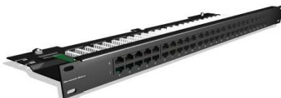
Pannello di permutazione telefonica
